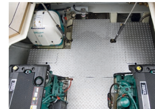
▲ Bijzonder ruim opgezette en technisch keurig uitgevoerde machinekamer onder de kuip.
